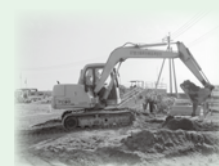
バックホー(0.25m³)による掘削作業
