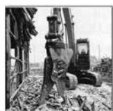
鉄骨切断機 (鉄骨を切断)
